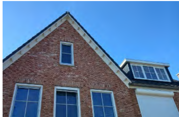
Dakoverstekken ook bij puntgevels. Dit geeft een geborgen gevoel en past beter bij dorpse bebouwing
