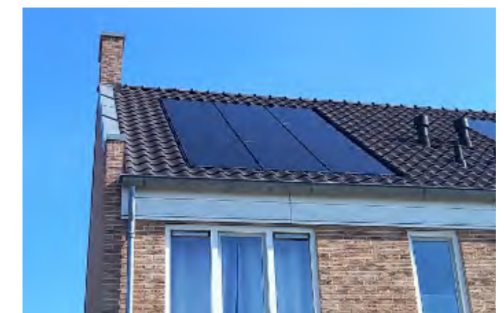
Voorbeeld van een dak waar de zonnepanelen zijn geïntegreerd in de dakbedekking
